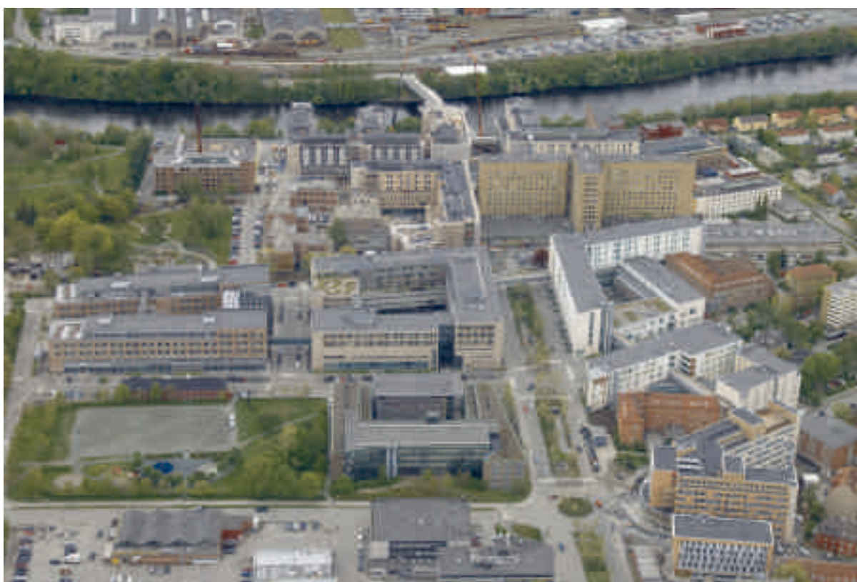
Figur 2. St. Olavs hospital, Trondheim fra øst i 2008. Foto: St. Olavs hospital.
